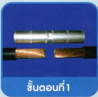
ขั้นตอนที่ 1 เตรียมหางปลาและสายไฟ
